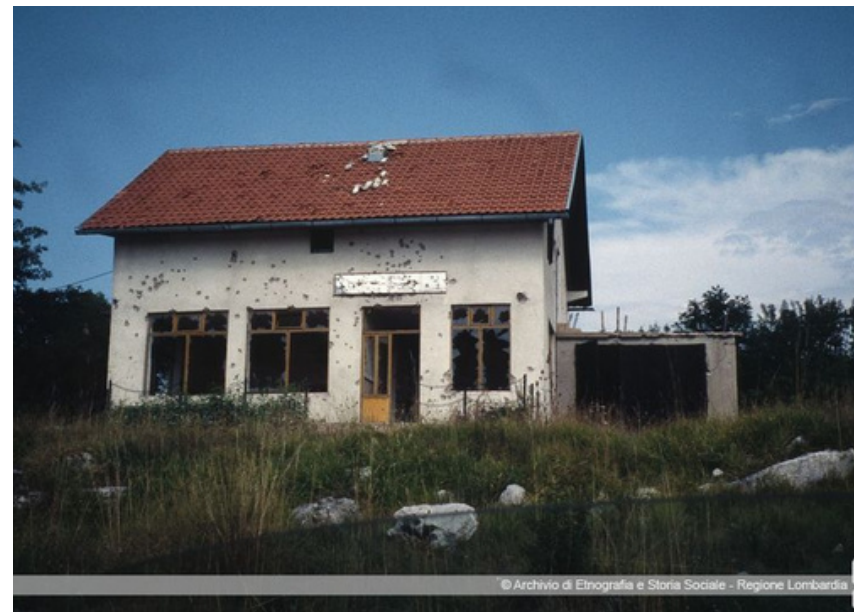
Edificio danneggiato durante la guerra dei Balcani ITE-OPD00-0000091803
